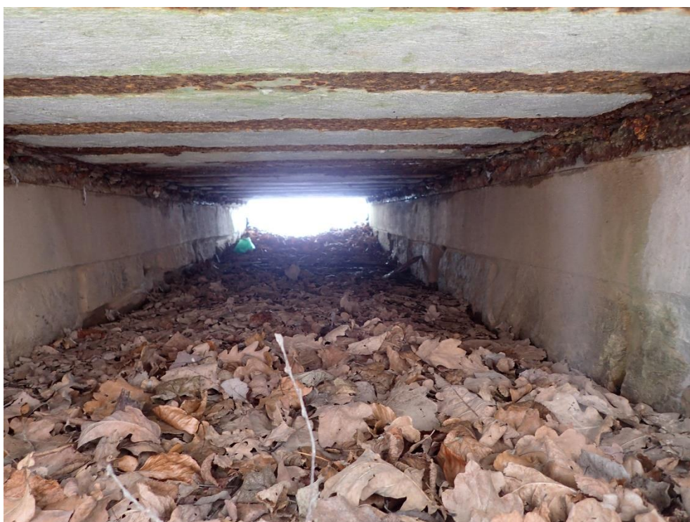
Foto 4: Koroze ocelových nosníků, výluhy, stopy po zatékání
