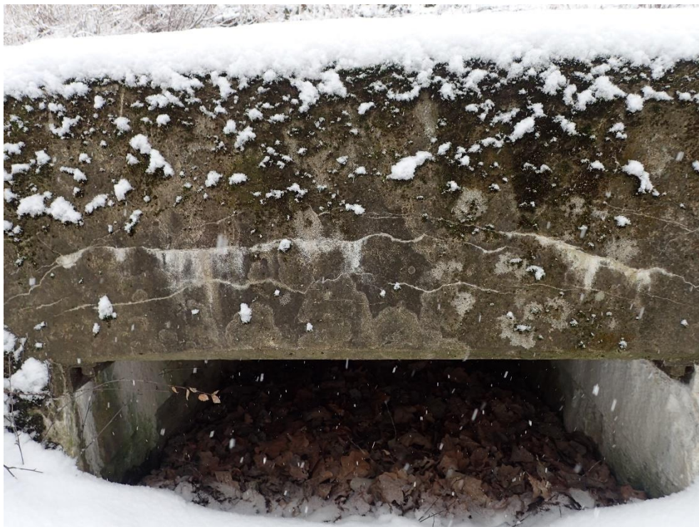
Foto 3: Praskliny a výluhy na čele propustku
